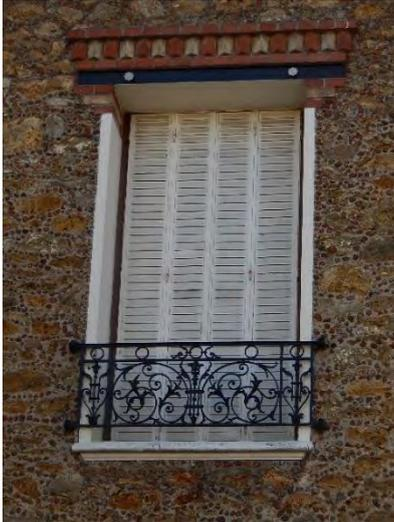
Élément à la fois de structure et de décor placé au-dessus des baies, composé d'une pièce de métal dont les rivets sont masqués par des rosettes, et d'un décor en brique bichromes ; garde-corps en ferronnerie.
