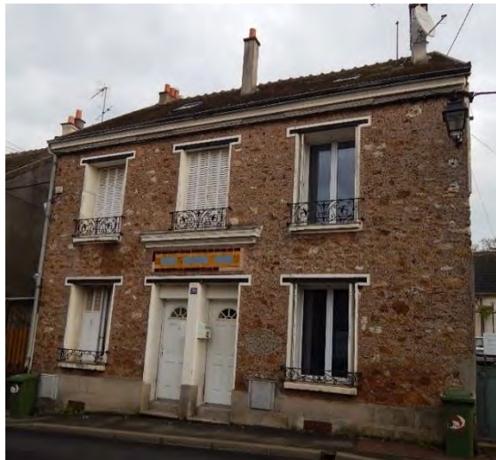
Ancienne Poste située Grande rue
