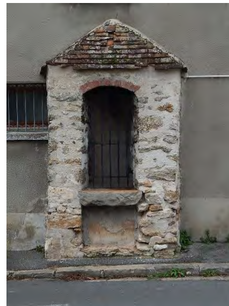
Ci-dessus, puits rue Haute
