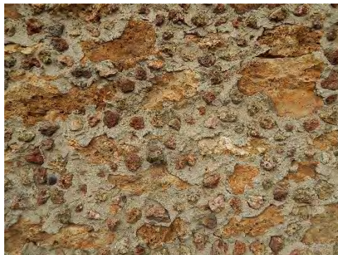
Meulière enduit avec rocaillage
