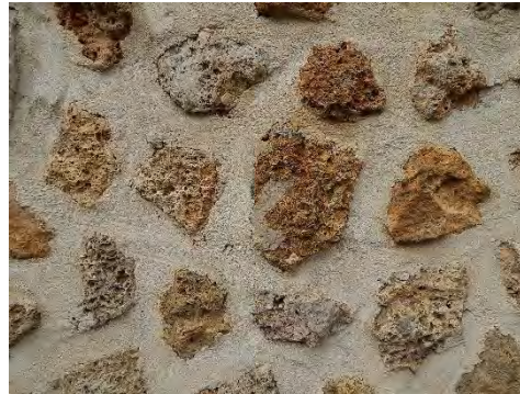
Moellon de meulière enduit à la chaux
