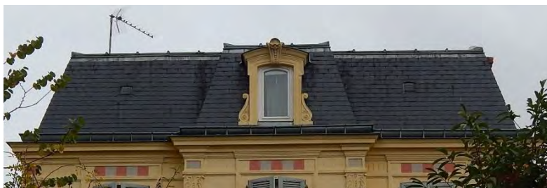
Toiture à croupe brisée en ardoise
