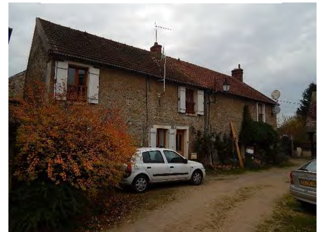
Maison rurale non composée rue Haute
