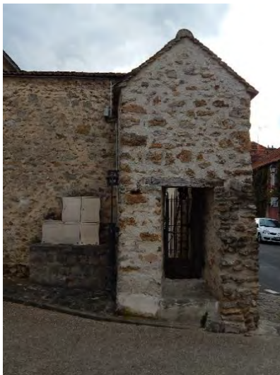
Ci-contre, puits rue de la Mairie
