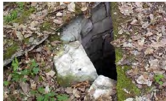
Puits de carriers
