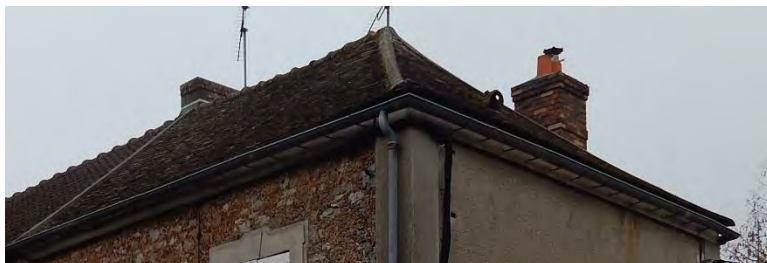
Toiture en tuiles plates à croupe
