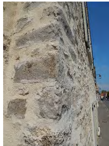
Chainage d'angle en grès
