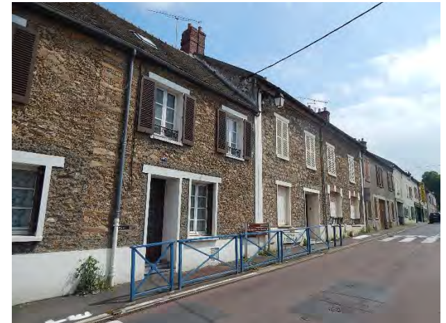
Maisons situées Grande rue
