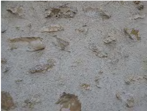
Moellon de calcaire enduit à pierre vue à la chaux
