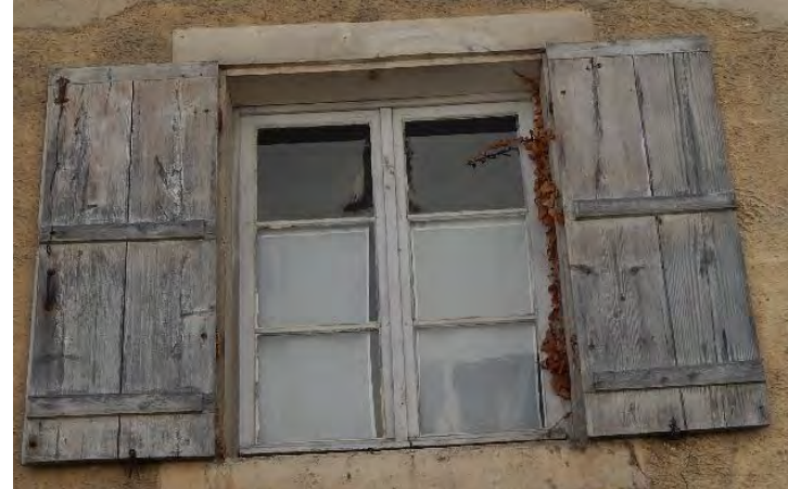
Volets à barre Grande rue
