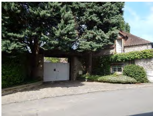
Entrée grande ferme - rue Basse
