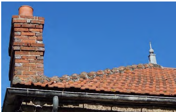
Toiture en tuiles mécaniques, souche de cheminée en briques
