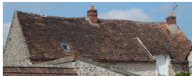
Toiture ancienne en tuiles plates
