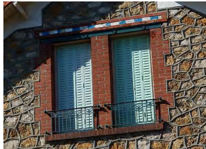
Volets persiennés repliable en métal rue de la Pingourdière
