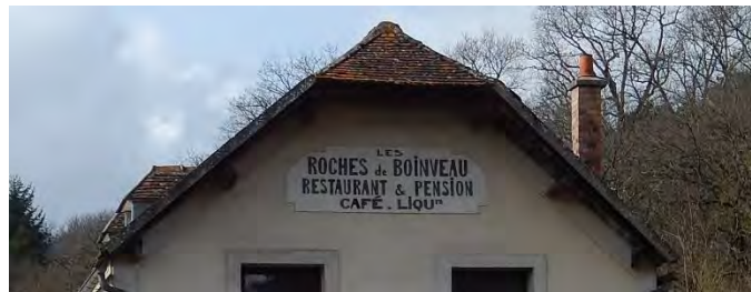
Toiture en tuiles plates à demi croupe
