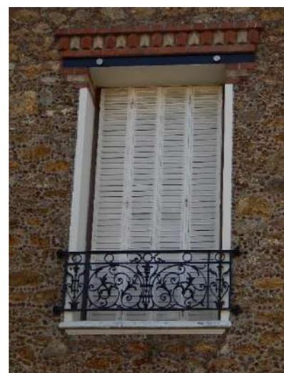
Linteaux composés de pièces de métal munies de rosettes et d'un décor en briques bichromes ; garde-corps en ferronnerie. Les baies de l'étage sont soulignées d'un bandeau d'appui identique aux linteaux.
