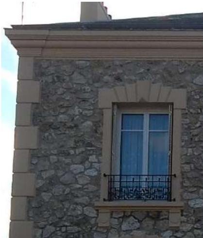
Corniche moulurée joue un rôle important sur l'aspect de la façade ; Baie au linteau en arc segmentaire et appui saillant ; chaînage d'angle.
